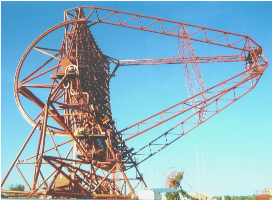
Abb. 6: Das Tscherenkow-Teleskop H.E.S.S. II in der Aufbauphase am 18.5.2012, links der erst im unteren Teil mit Spiegeln belegte Spiegelträger, rechts am Ende des Auslegers der Platz für die Kamera, im Hintergrund ein H.E.S.S. I-Teleskop
