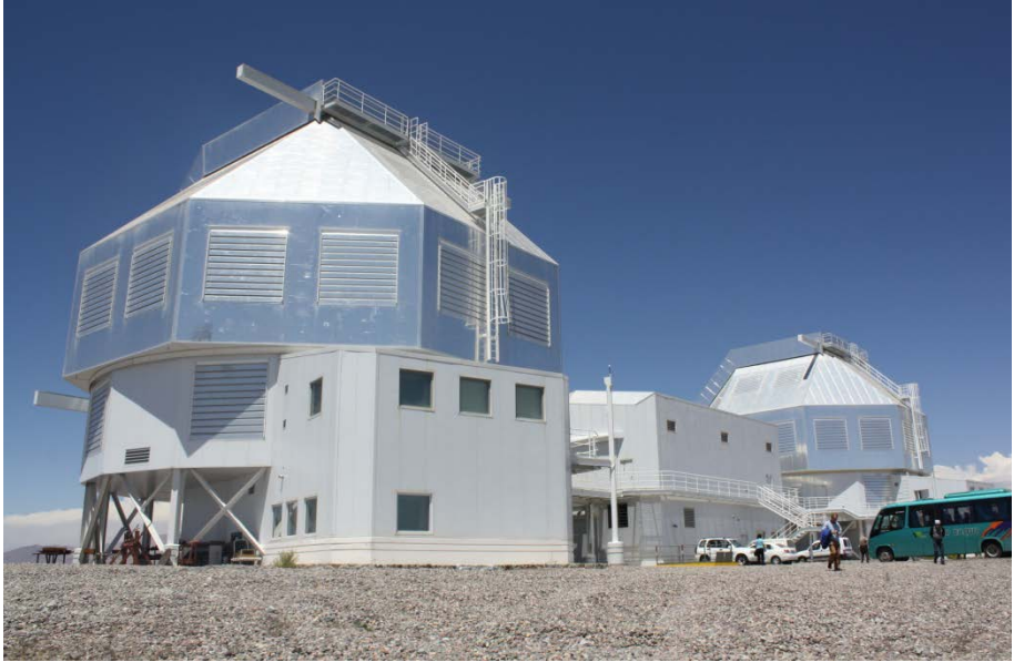
Abb. 4: Las Campanas. Die beiden Observatorien mit 6,5 m-Spiegel-Teleskopen, dazwischen die Halle mit der Verspiegelungseinrichtung
