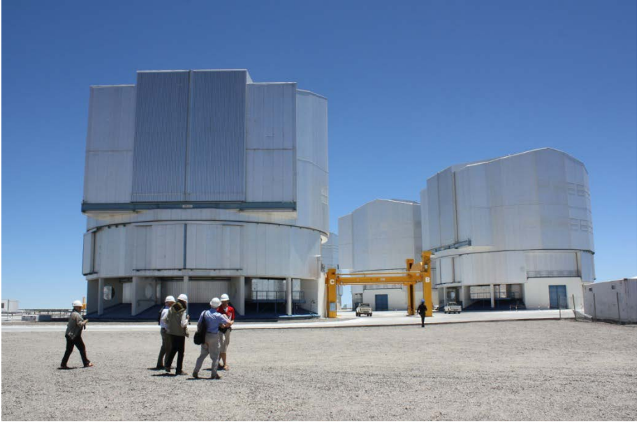
Abb. 7: Cerro Paranal. Drei der vier Schutzbauten mit den 8,2 m-Spiegelteleskopen auf dem planierten Berggipfel
