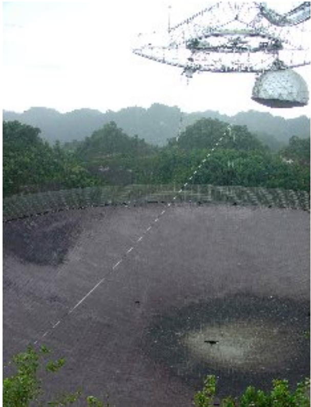
Abb. 1: Reflektor mit Empfängerkonstruktion in 137 m Höhe. Die Kuppel (Gregorian dome) enthält den Sekundär- und Tertiärreflektor.
