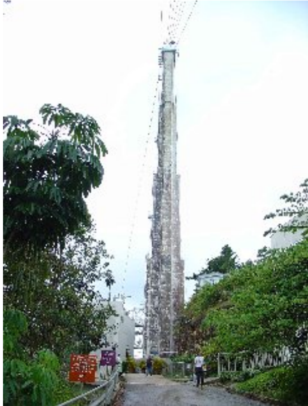
Abb. 2: Einer der Masten, die das Empfängersystem (630 t) tragen und auf Position halten. Direkt daneben befindet sich das Besucherzentrum.
